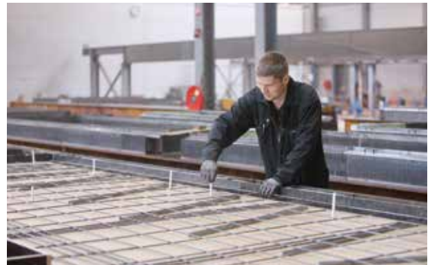
Schöck Isolink® type TA-HC in de voorgeboorde isolatielaag aanbrengen.
