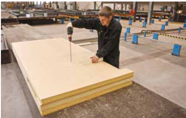
Isolatiepanelen op de vers gebetonnerde deklaag leggen.
