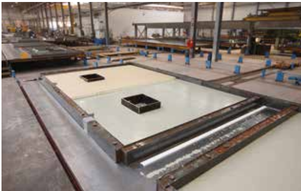
Gaten in het isolatiemateriaal voorbereiden.
